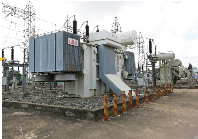
Trạm điện phân phối
