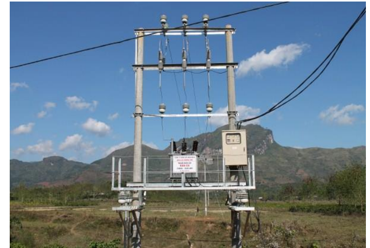
Trạm biến áp
